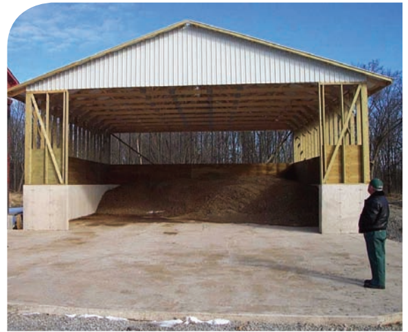
Installation permanente d'entreposage de fumier solide
