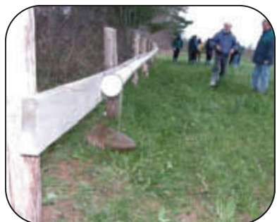
Figure 4 : Un tuyau de distribution présentant de trous de 1/2 po à des intervalles de 17 po répartit l'écoulement uniformément sur toute la bande
