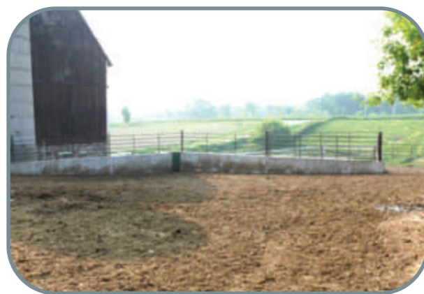
Figure 1 : Enclos muni d'une cloison de retenue servant de stockage temporaire pour l'écoulement
