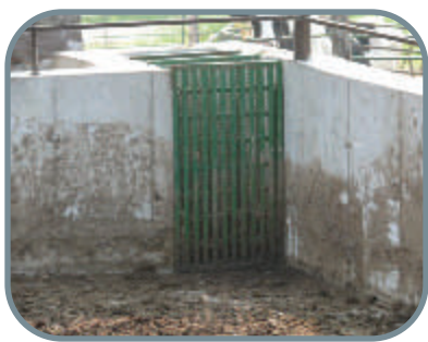
Figure 2 : Trois grilles réduisent la quantité de matières solides pompées sur la bande
