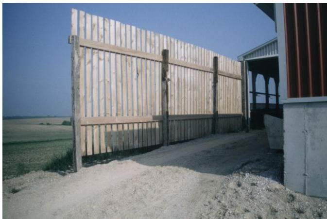
Figure 3. Brise-vent en bois où on peut voir les espaces entre les planches
