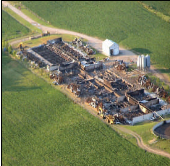
Figure 4. Bâtiment incendié. Remarquez la taille de l'excavatrice par rapport au bâtiment. Photo : avec la permission de Randy Drysdale.
