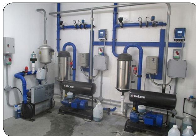
Figure 1. Local technique exempt d'objets encombrants, de poussière et de débris. Source : Heartland Farm Mutual, Ontario.
