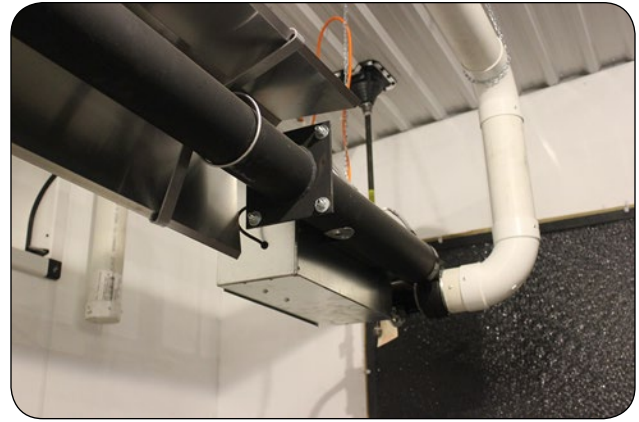
Figure 8. Générateur de chaleur à tube radiant suspendu dans un bâtiment d'élevage.
