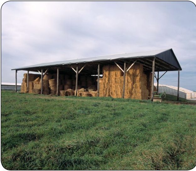
Figure 10. Structure d'entreposage indépendante pour le foin et la litière. Source : Farm and Food Care.
