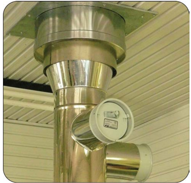
Figure 9. Cheminée en acier inoxydable à double paroi entourant le tuyau de ventilation à l'endroit où il traverse un plafond, un plancher ou un mur isolé.
