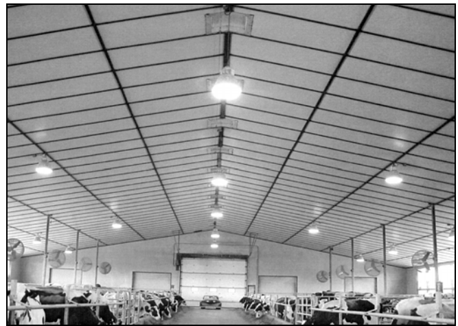
FIGURE 7. Luminaires à lampe aux halogénures métalliques.
