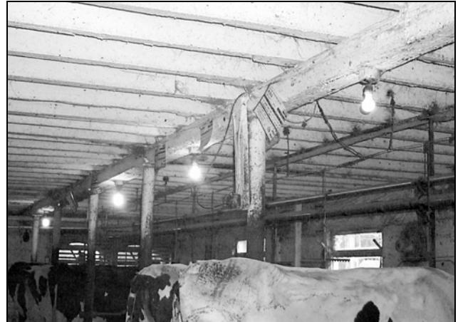
FIGURE 5. Combinaison d'ampoules incandescentes et de lampes fluorescentes compactes dans une étable laitière.
