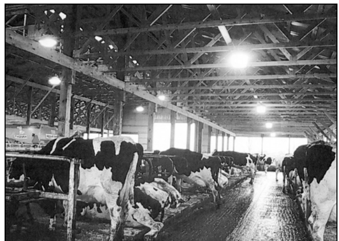
FIGURE 8. Luminaires au sodium à haute pression (émettent une lumière jaune). (Source : Agviro, Inc.)
