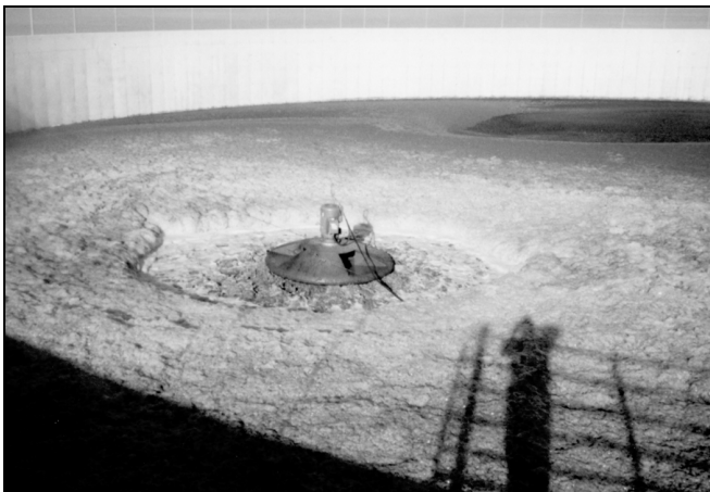
Figure 2. Aérateur de surface flottant à hélices en action. (Photo offerte par Jacques Whitford Consulting)
